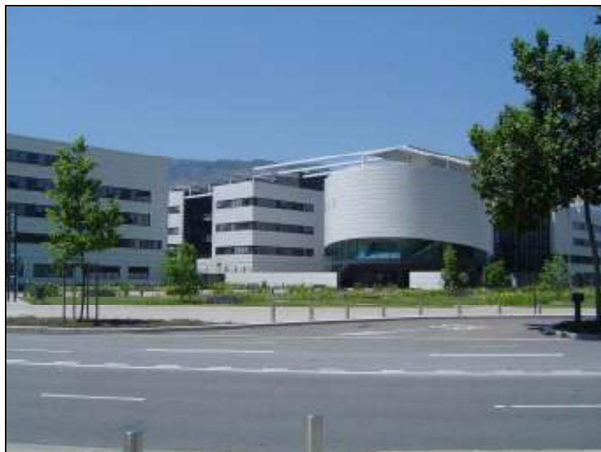
Vista das instalações do MINATEC em Grenoble, França.
